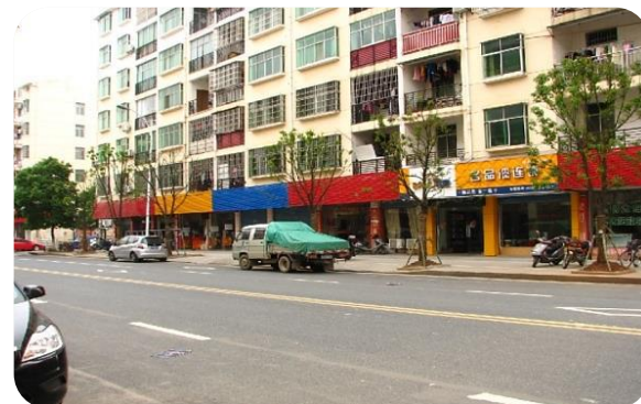
03 跃进路广告牌改造
